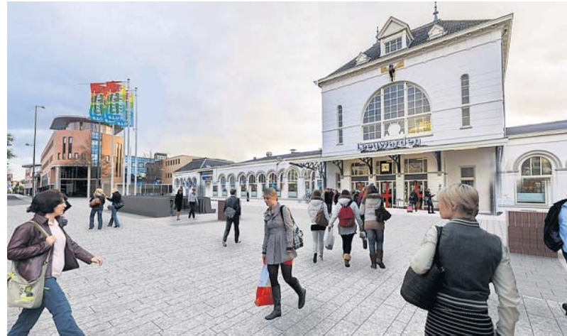
Het stationsgebied wordt ingericht met grijze gespikkelde stenen. Op het plein komt een ingang naar de ondergrondse fietsstalling. AFBEELDING GEMEENTE LEEWARDEN
